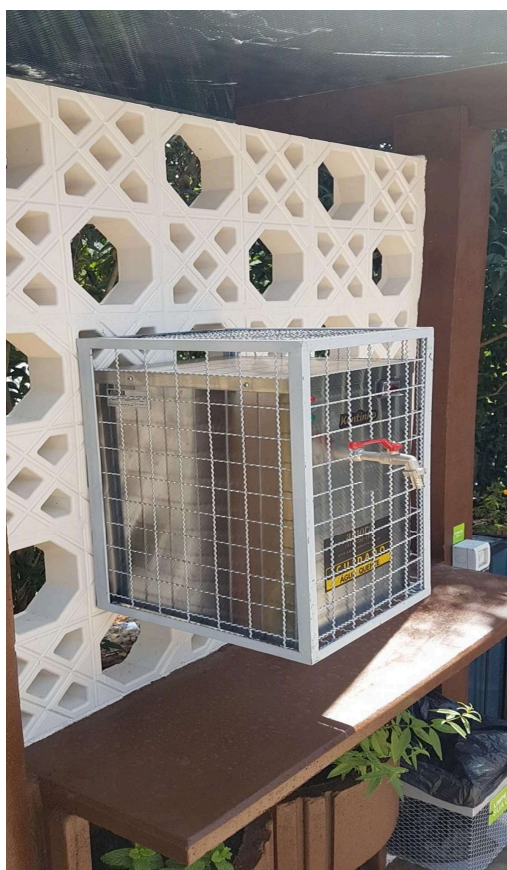
Exemplo do aquecedor de água, tampo de apoio e cobogós.
