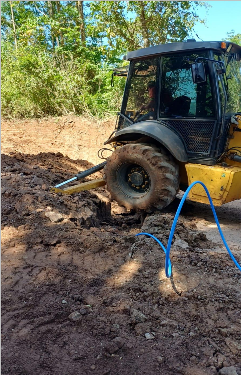
Melhoria na rede da Rodovia Trascitrus
