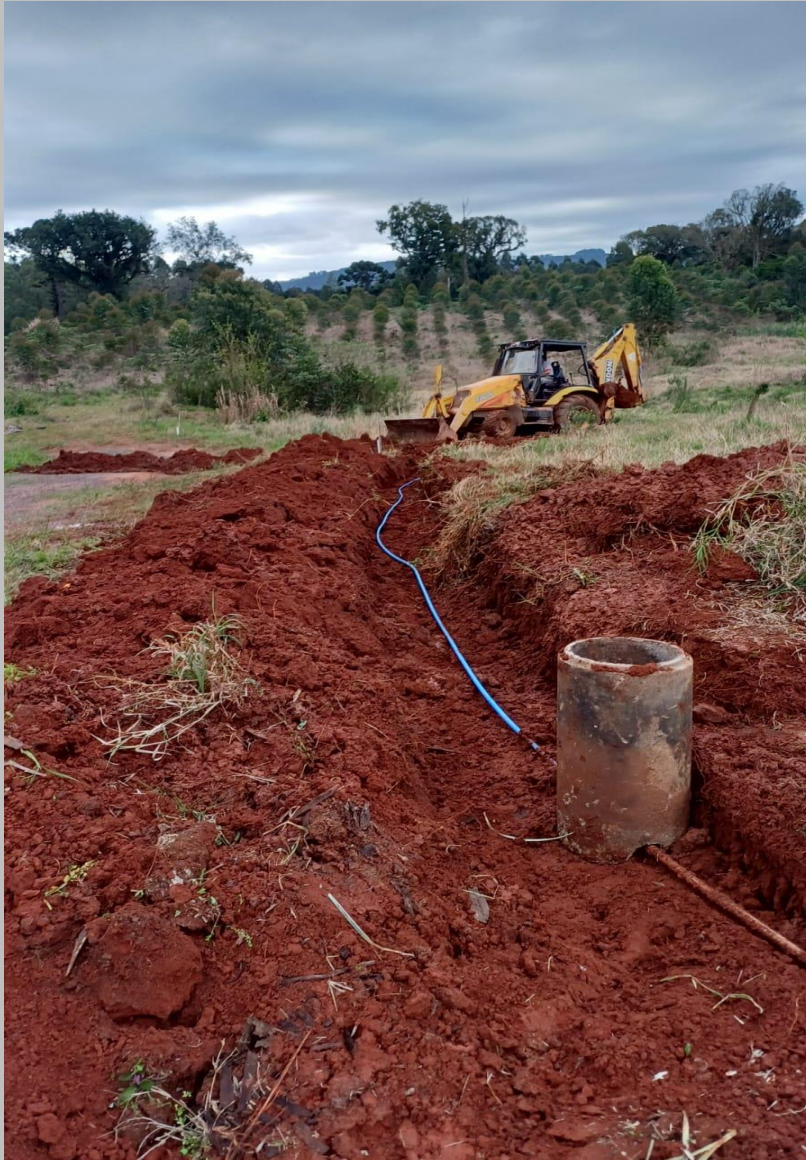
Extensão de rede na rua Pedro Kolling
