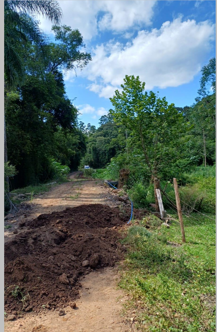
Extensão de rede na localidade Água Fria.
